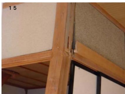
柱の破損
